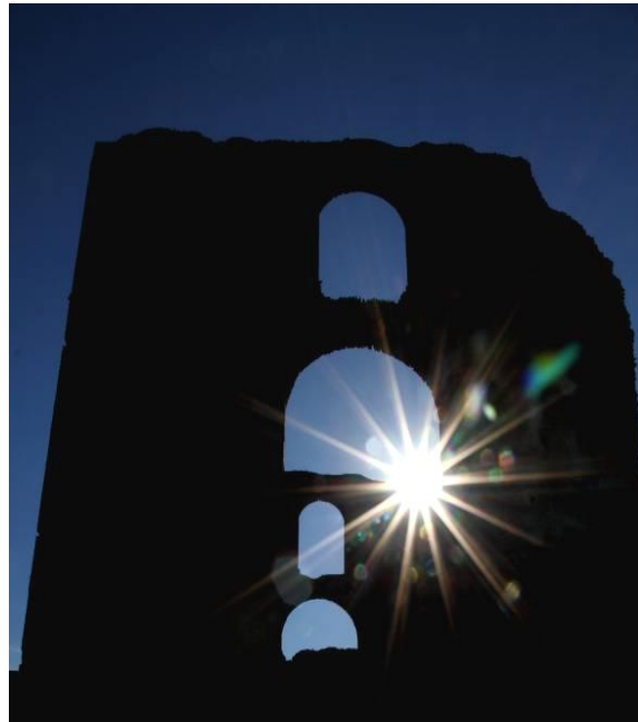
Villa dei Quintili: finestre del calidarium (foto R. Frontoni, archivio SSBAR).
