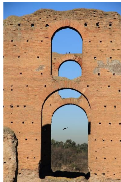
Fig. 10 - Villa dei Quintili, grandi finestre sovrapposte lungo i lati brevi del calidario (foto R. Frontoni, archivio SBBAR)
