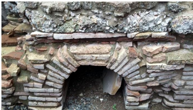
Fig. 17 - Villa dei Quintili, condotto del forno, scoperto sotto al pavimento di una delle sale del tepidario (foto G. Galli, archivio SBBAR).
