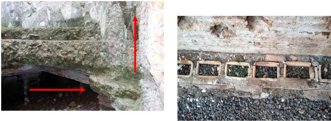
Figg. 13-14 - Villa dei Quintili, intercapedini sotto il pavimento ( suspensura ) e lungo le pareti ( tubuli ) nascoste dietro ai rivestimenti, in una delle stanze termali.
