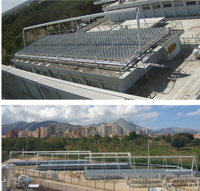
Fig. 1 - Collettori LFR installati ad Aglantzia (in alto) e Palermo (in basso)
