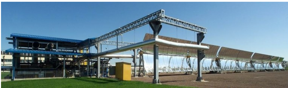
Fig. 3 - Impianto Prova Collettori Solari (PCS) dell'ENEA-Casaccia
