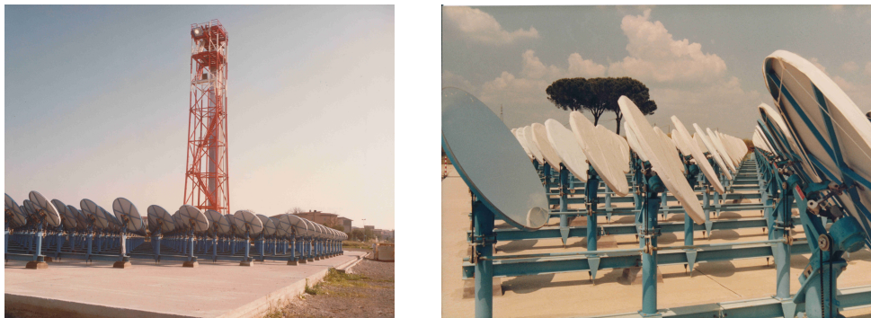
Fig. 1 - Torre solare CTSTF installata nel 1982 nell'area Capanna del centro ENEA-Casaccia. A destra un particolare del meccanismo di movimentazione per file di specchi
