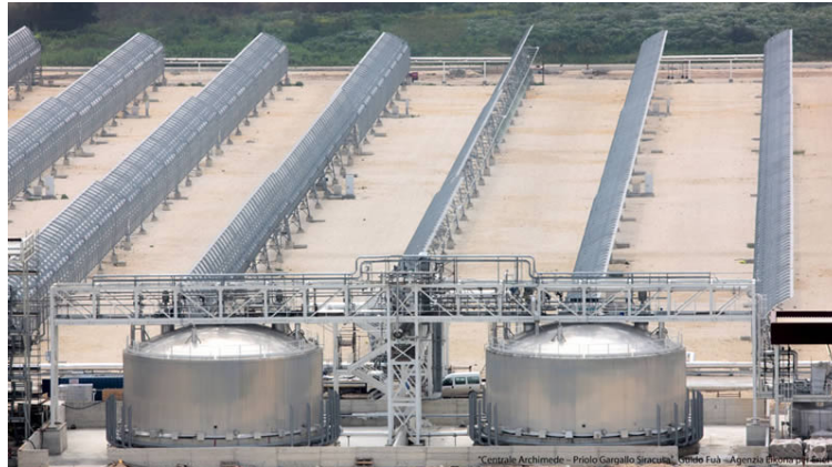
Fig. 4 – Impianto ENEL Archimede di Priolo Gargallo (Siracusa)
