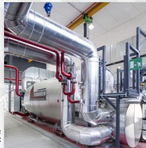
Figura 9: modulo ORC ad alta efficienza, Turboden 12 HRS
