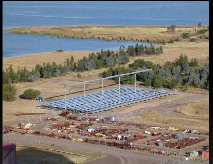
Visualizzazione del progetto di un impianto solare a concentrazione puntuale o multitorri fresnel, il cui antenato è l'impianto prototipo che Giovanni Francia costruì nel 1965 a S. Ilario.
