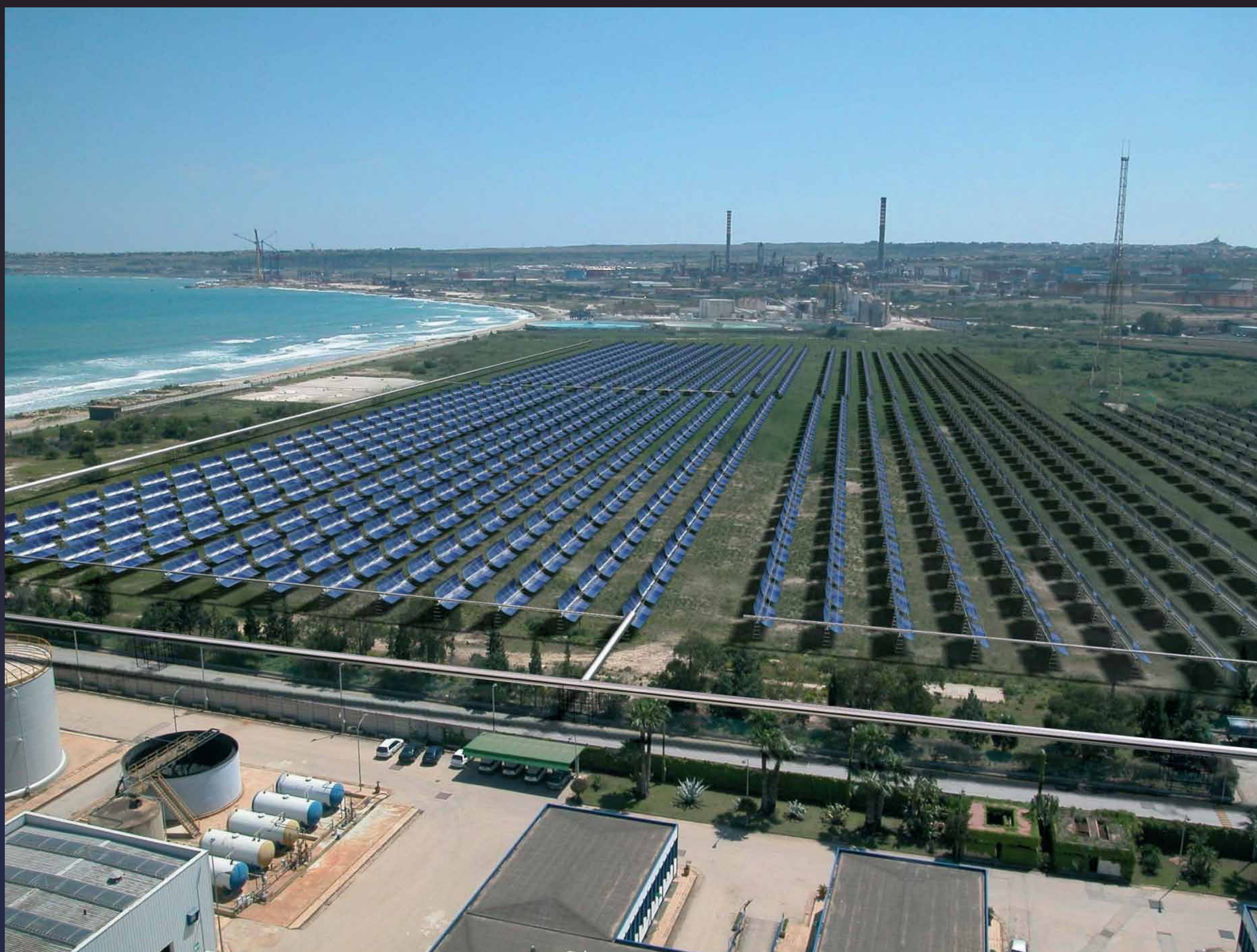
Elaborazione grafica del campo specchi della Centrale Archimede di Priolo Gargallo.
