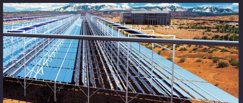
Visualizzazione di un progetto di un impianto solare a concentrazione a torre fresnel multitorre sul tetto della sede centrale della BMW di Monaco. David Mills e Philipp Schrameck, 2002.
