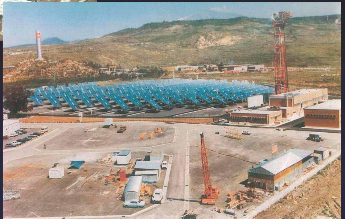
Adrano (Catania) 1981 – La centrale solare Eurelios da 1 MW a concentrazione puntuale o a torre.
