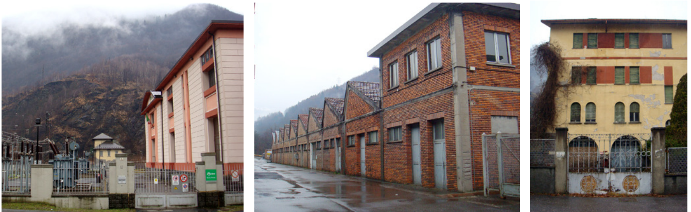
Da sinistra: Centrale Idroelettrica di Forno Allione, Elettrografite Forno Allione, edifici di servizio caduti in disuso.
